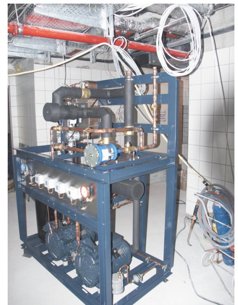
Verbundanlage mit Dorin-Verdichtern zum Zeitpunkt von Anlieferung und Montage
